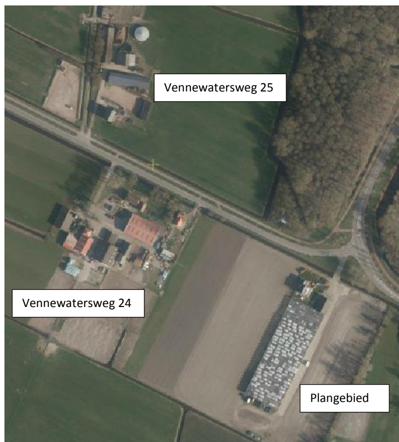
Figuur 4: luchtfoto plangebied, Vennewatersweg 24 en 25, bron: Globe Spotter
