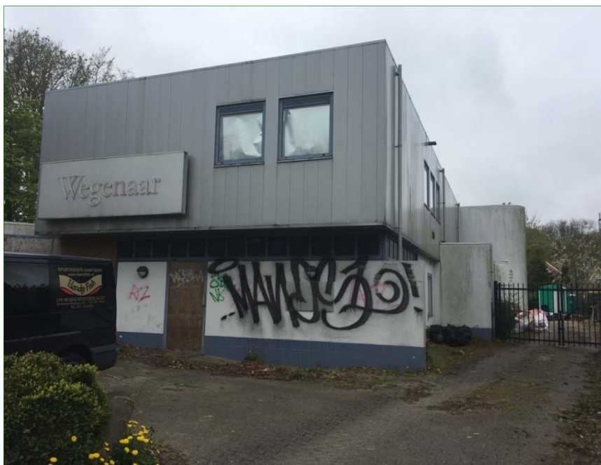
De voorzijde van het kantoorgebouw.
