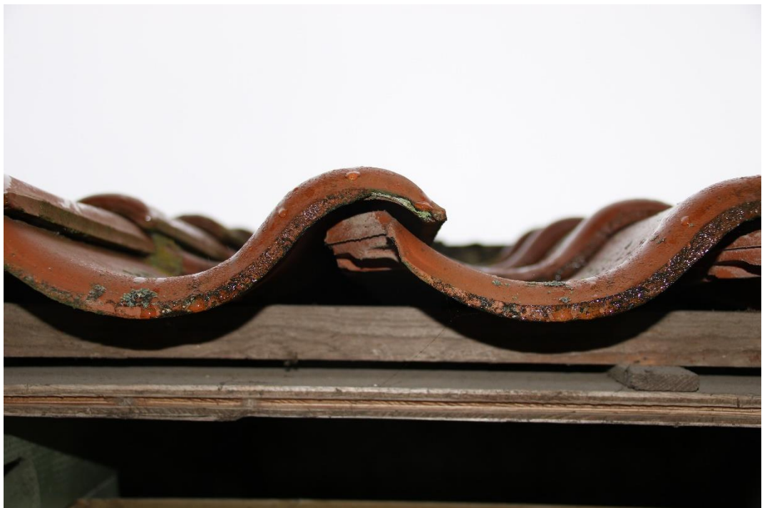
Onderzijde van het schuine dak
