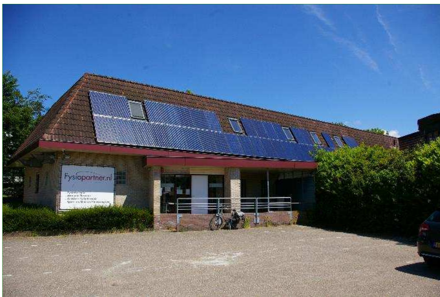
De ruimtes achter de zonnepanelen geven mogelijk toegang tot voor Huismussen geschikte achterliggende ruimtes.
