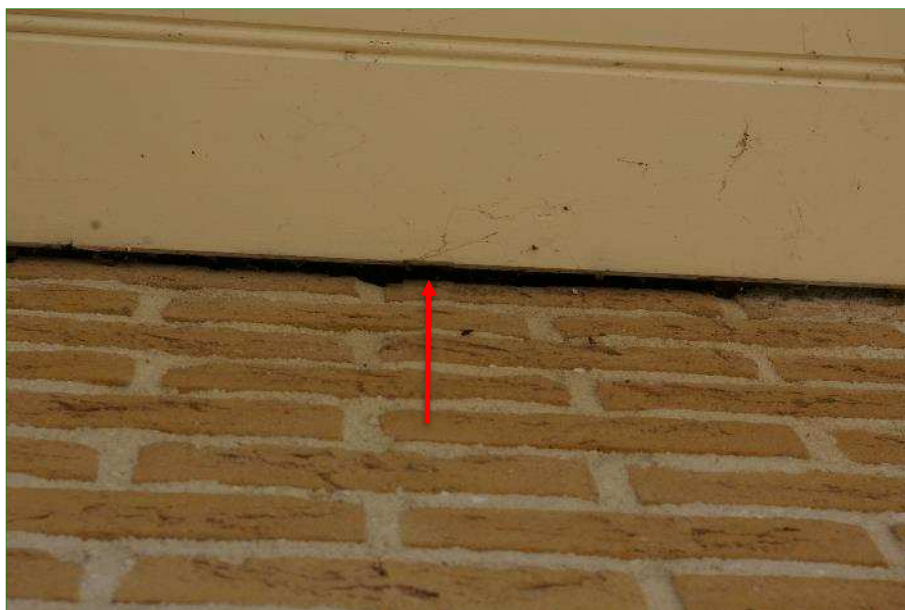
De openingen onder de dakrand (rode pijl) aan de oost, zuid en westzijde van de bebouwing geven mogelijk toegang tot voor vleermuizen geschikte achterliggende ruimtes.
