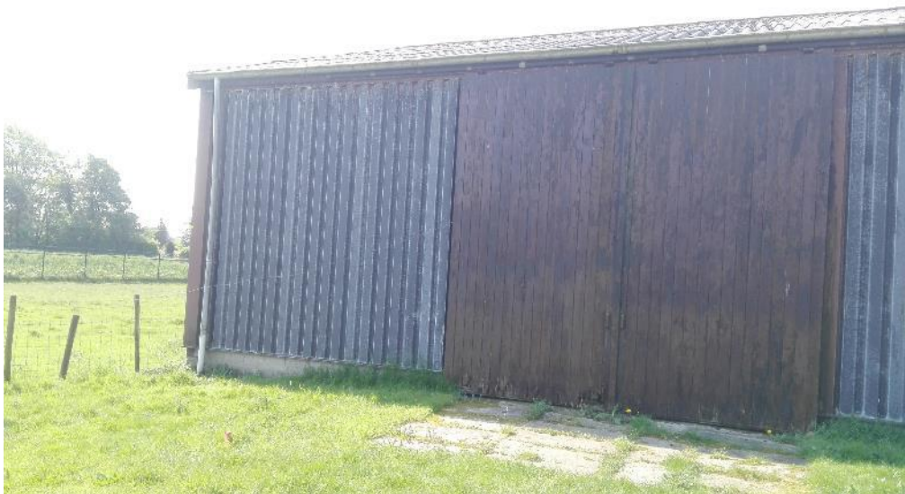
Figuur 4 Schuur 4 is niet geschikt voor vleermuizen. De schuur is volledig opgetrokken uit golfplaten en bevat ook een golfplaten dak. Er bevinden zich geen ruimtes waar vleermuizen zich mogelijk kunnen huizen.
