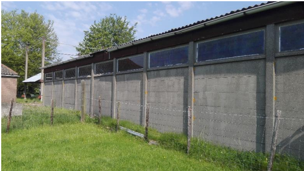
Figuur 3 Schuur 6 bevat openingen voor vleermuizen maar is minder geschikt vanwege het snel opwarmende dak.
