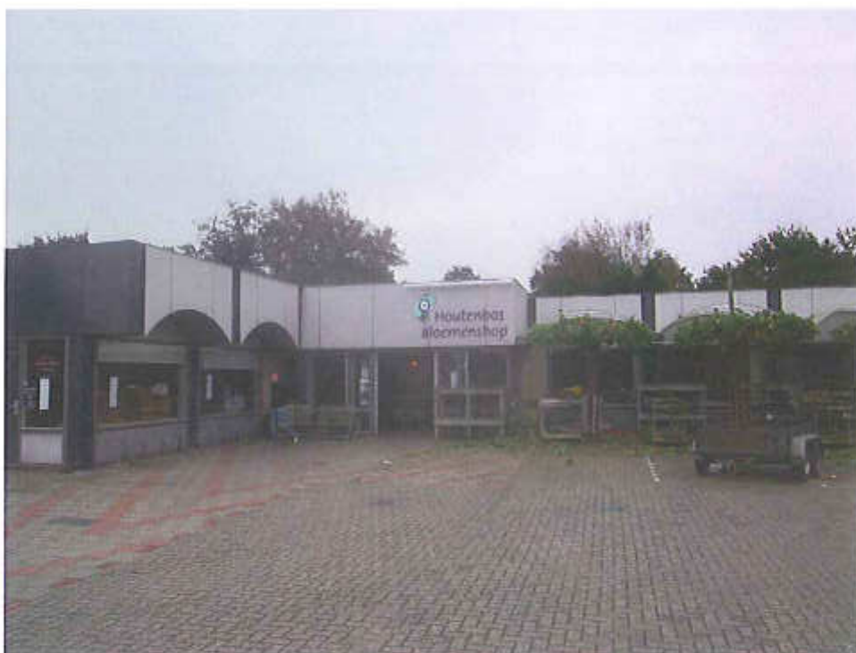
Foto 1: Overzichtsfoto pand; geen asbest aangetroffen
