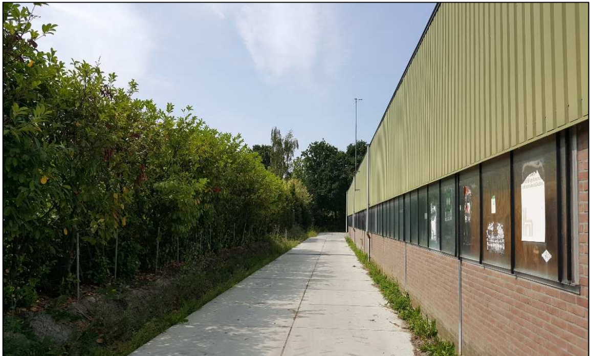
Schuur die voor een deel bestaat uit gemetselde muren en voor een deel uit stalen wandplaten.
