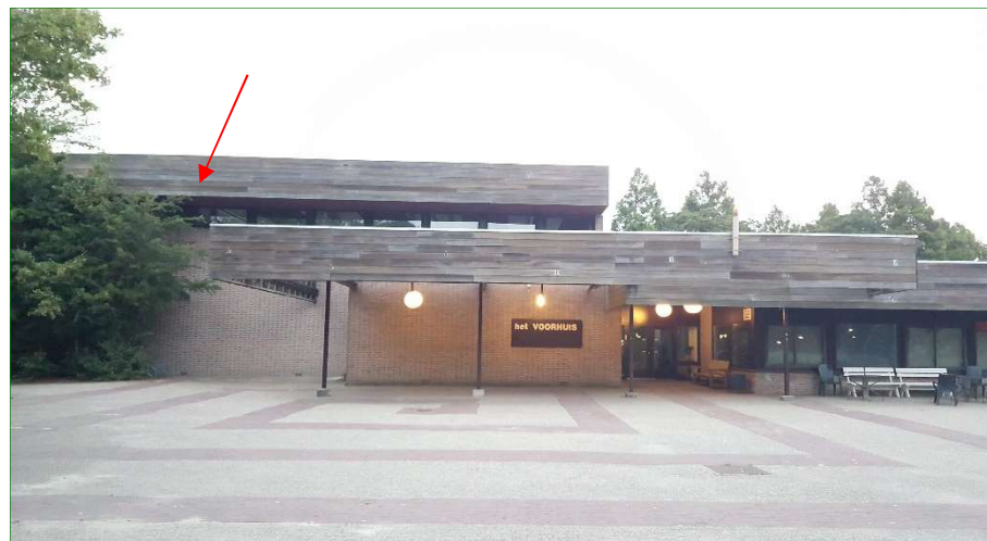
Zwembadgebouw waar Gewone dwergvleermuizen, Ruige dwergvleermuizen en Baardvleermuizen verblijven. Een van de verblijven is met een rode pijl aangegeven.
