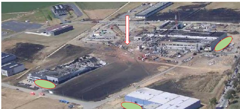
Figuur 12. Schaduwzijde gebouwen binnen fatale hittestralingsgebied. Pijl markeert centrum van de uitgedoofde fakkel. Groene ellips = schaduwzone.
