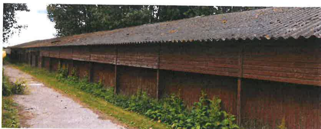
Bedrijfsgebouw 1 - circa 950 m 2 met een volume van 3325 m 3
