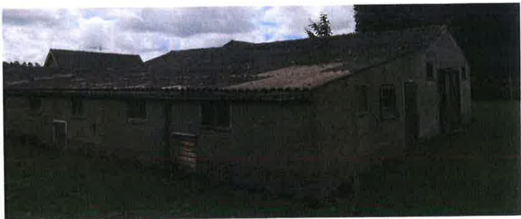
Bedrijfsgebouw 3 - circa 230 m 2 met een volume van 740 m 3
