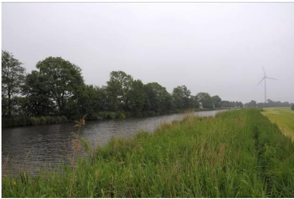
Kanaal Alkmaar (Omval)-Kolhorn t.h.v. de brug
