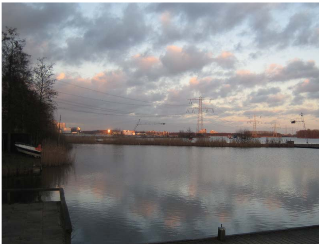
Lido, Almere, startmast en mast 5, gezien vanaf de achterzijde van omliggende huizen
