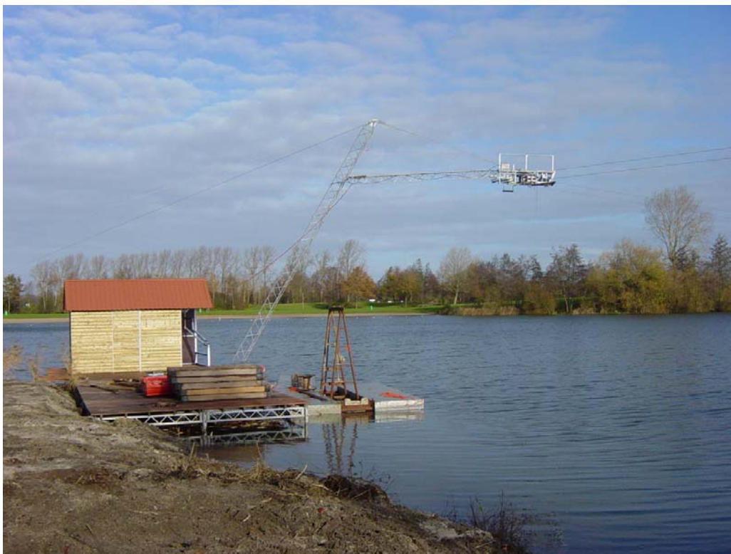
Waterskicentrum Kievitsveld, startmast en platform in aanbouw gezien vanaf de kant
