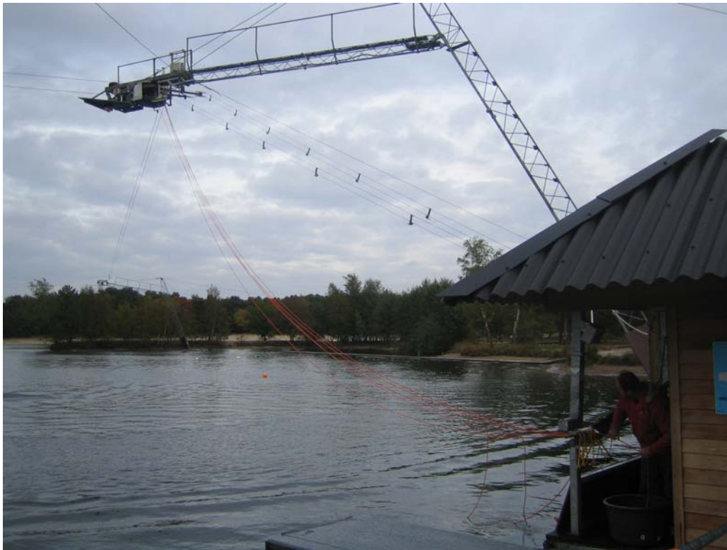
Center Parcs, Kempervennen, startmast en mast 5 gezien vanaf het startplatform
