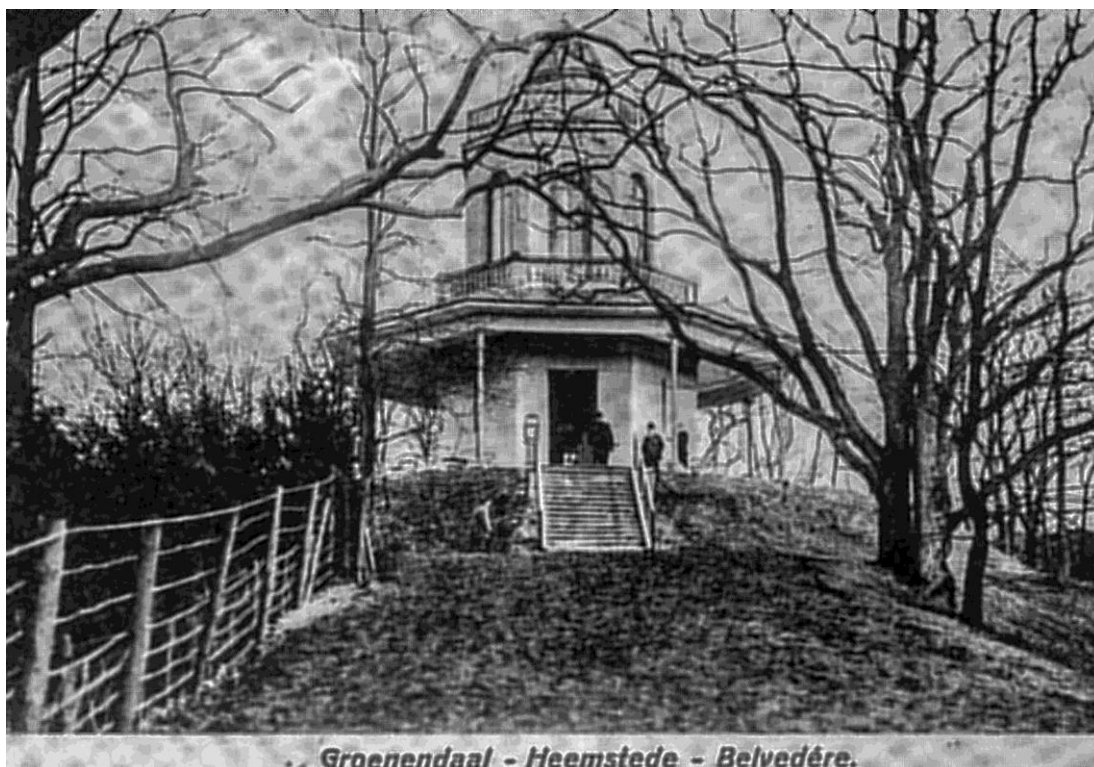
Figuur 1.1 De voormalige Belvédère (Bron: Heemstede.nieuws.nl)
