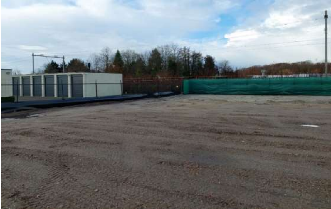
Figuur 2: De zuidwestelijke hoek van het perceel Leidsevaartweg 15. Het gehele terrein is omgeven met hekwerken/rasters/bouwhekken. Op achtergrond spoorlijn Heemstede-Leiden.
