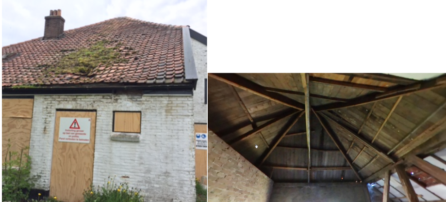
Afbeelding 3. Het dak aan de buiten- en binnenzijde
