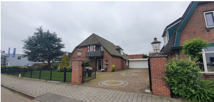
Het woonhuis (rechts) met de naastgelegen woning. Foto: K. de Vries / Ecoresult B.V.
