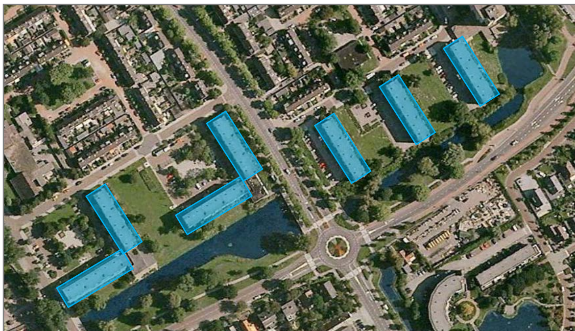
Afbeelding 3.2 | Luchtfoto van de huidige situatie met de te slopen galerijflats
