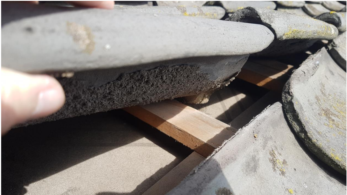
Foto 9: bij het lichten van de pannen kon een hele rij mee gecontroleerd worden. N.B. is het erg schoon onder de dakpannen.
