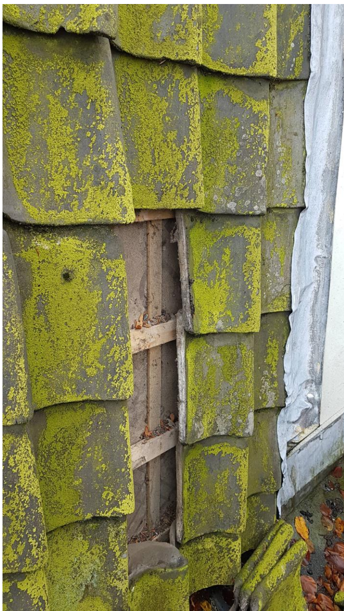
Foto 8: onder de dakpannen op het dakbeschot is 2 jaar terug een nieuwe vochtwerende folie geplaatst. Ook de loodslabben sluiten nauw aan.
