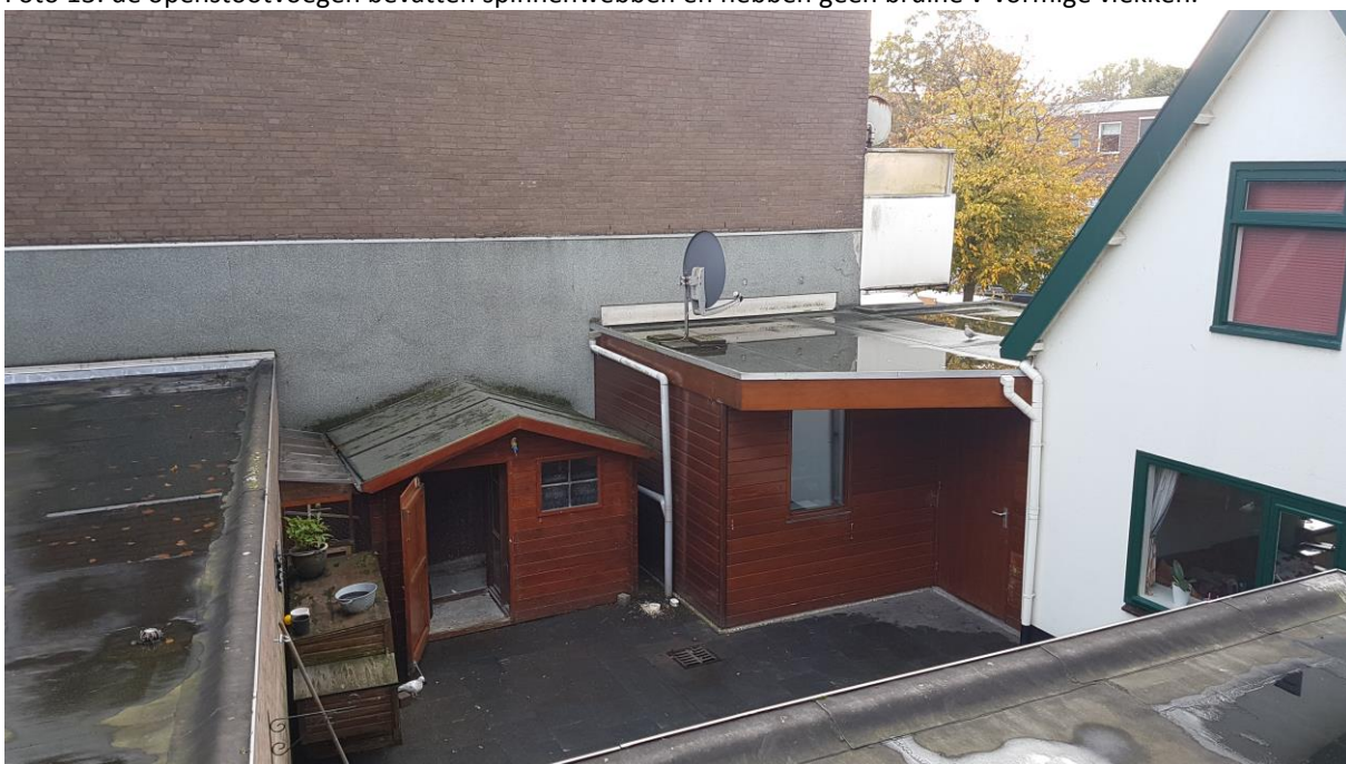
Foto 14: het binnen hofje met de schuurtjes waarin grasparkieten worden gehouden. Het aangebouwde deel links wordt niet gesloopt. het nieuw te bouwen deel komt tegen de huidige gevels aan. In de gevel van het buur perceel zitten geen open stootvoegen of scheuren.
