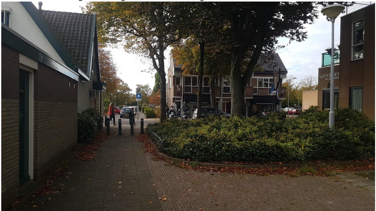
Foto 12: links is de onderzoekslocatie met de nieuwe aanbouw vooraan. Tot en met de deur wordt gesloopt. in de muur zitten openstootvoegen waar de lantaarnpaal (rechts) op schijnt.
