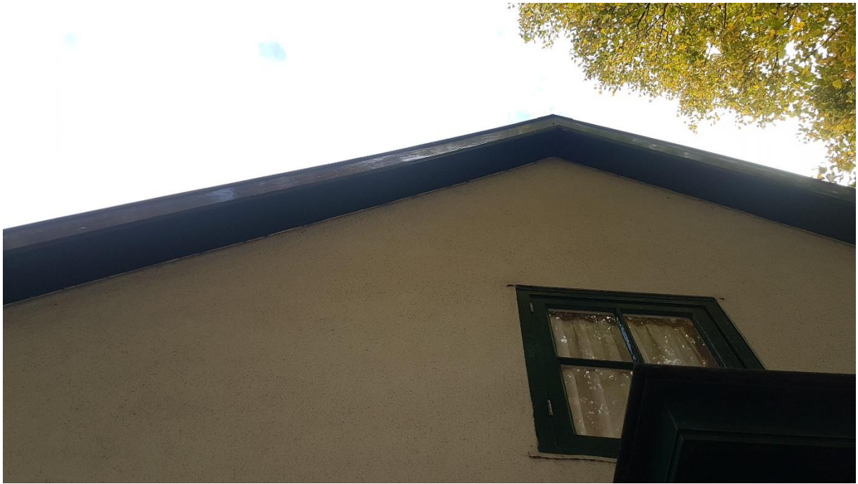
Foto 6: De gevel is goed onderhouden en er is geen ruimte tussen de dakrand en de gevel.
