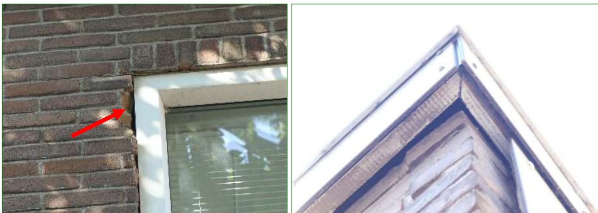
Gaten in de muren naast de kozijnen (links) en spleten onder de boeidelen op de dakrand (rechts) geven mogelijk toegang tot voor vleermuizen geschikte achterliggende ruimtes.
