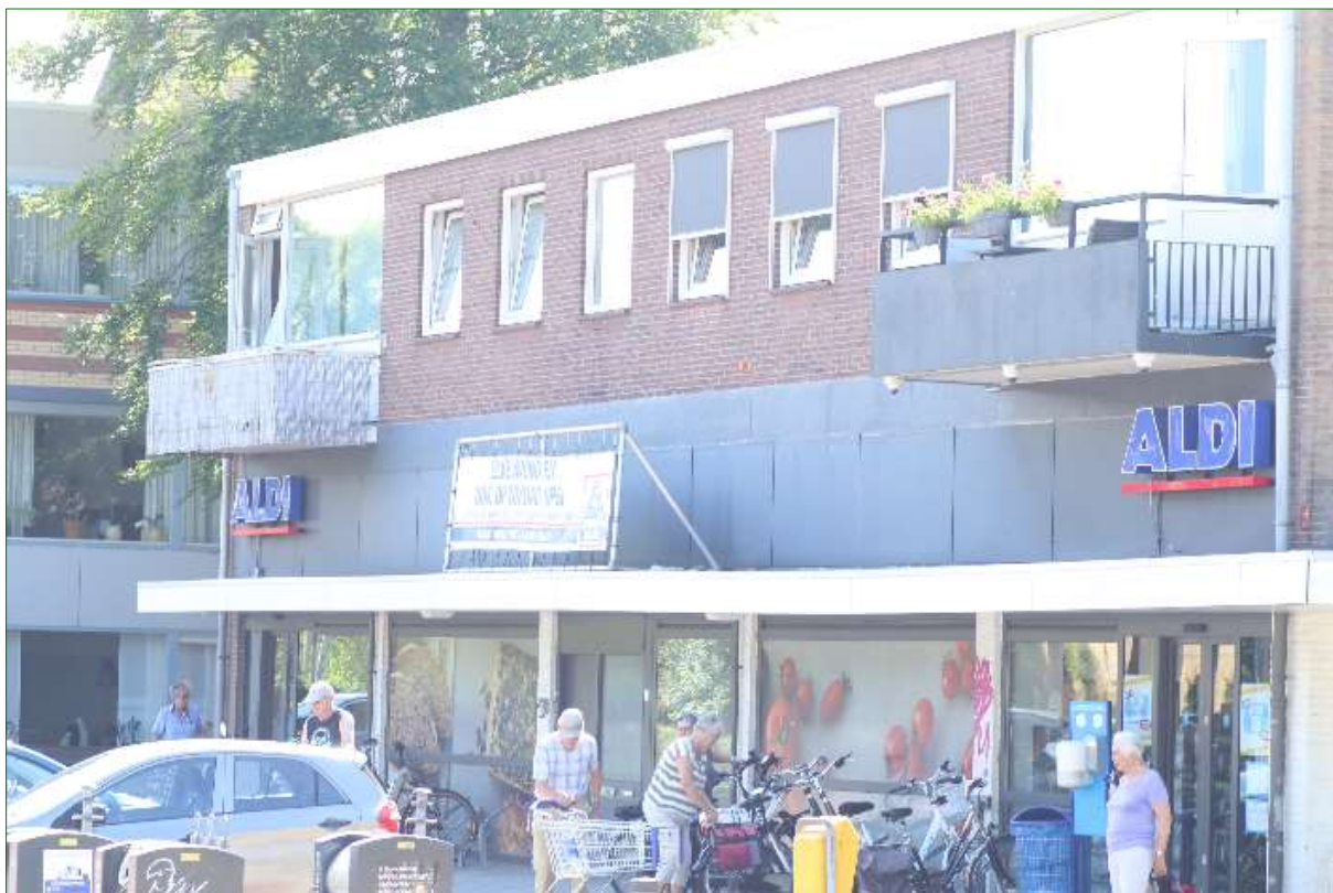
Oostgevel van de bebouwing met op de begane grond de winkel en op de eerste verdieping appartementen.
