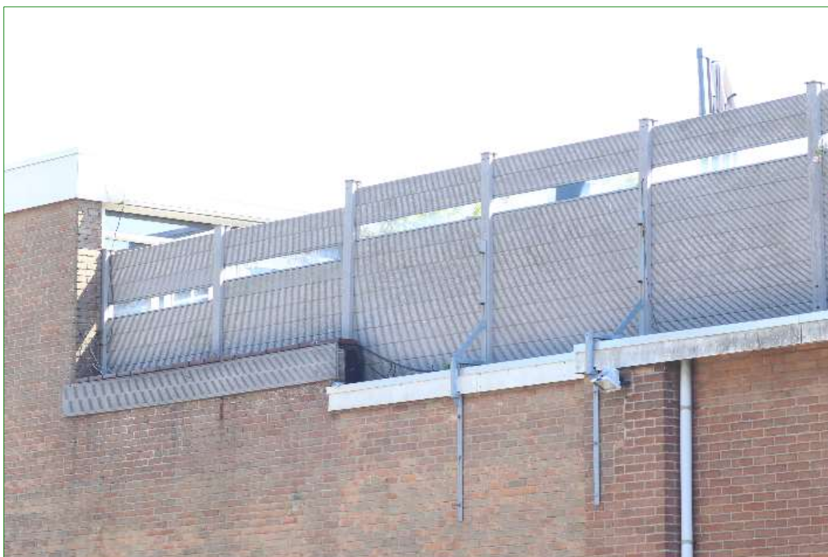
De appartementen hebben een dakterras aan de achterzijde welke zijn gescheiden door schuttingen (hier de noordgevel).
