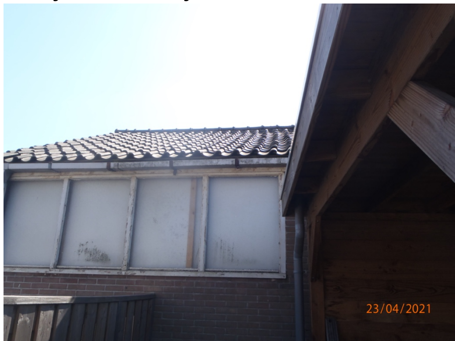
Afbeelding 8. Het dak van de loods gezien vanaf de achtertuin van de burens
