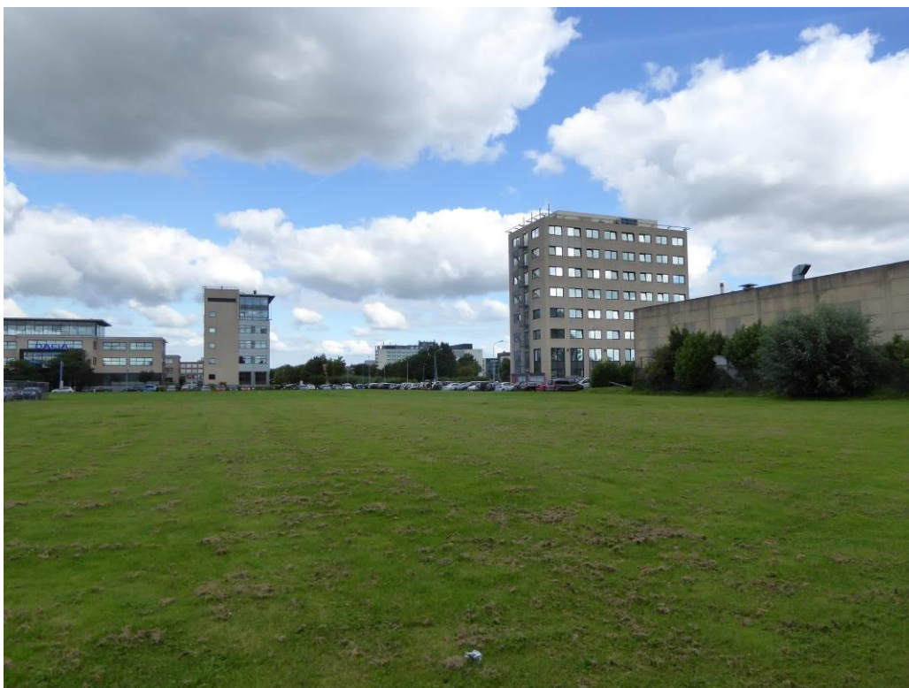
Foto van de bebouwing langs de Boeing Avenue (genomen vanaf de Molenweg in noordelijke richting)
