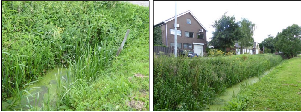
Watergang in het zuiden van het plangebied.
