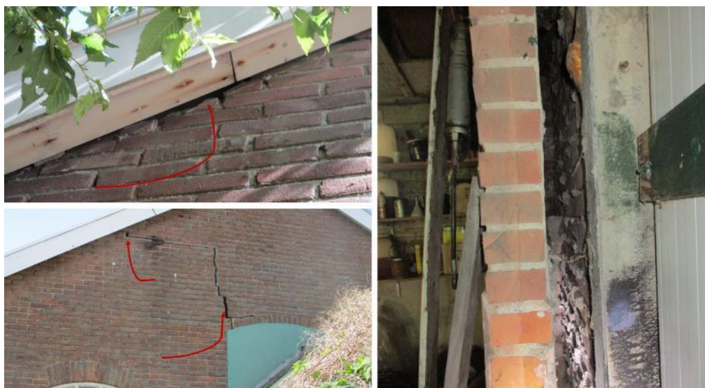
Figuur 4 Potentiele toegang naar achterliggende ruimte, echter doordat de spouwmuur aan de noordwestzijde geheel openligt ontstaat er een tochtstroom en is de spouwmuur niet geschikt als vaste rust- en/of verblijfplaats voor vleermuizen.
