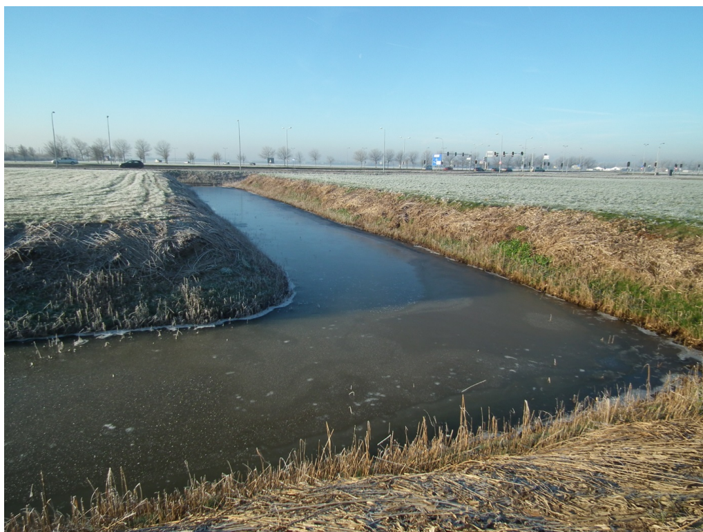
Figuur 2 Binnen het plangebied is een brede watervoerende sloot gesitueerd. Mogelijk wordt de sloot (deels) gedempt of aangepast.
