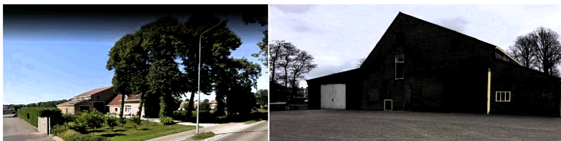
Impressie woonboerderij [REDACTED]. Linker afbeelding toont aanzicht vanaf de IJweg in de richting van de woonboerderij. Rechter afbeelding toont aanzicht op de grote schuur vanaf het achterterrein. (bron: De Beemgaard)
