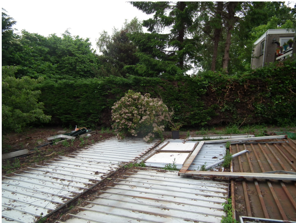
Figuur 3 De overige terreininrichting bestaat uit verwaarloosde sier- en moestuin. Op de locatie zijn tevens sloopmateriaal, rommel en spullen opgeslagen.
