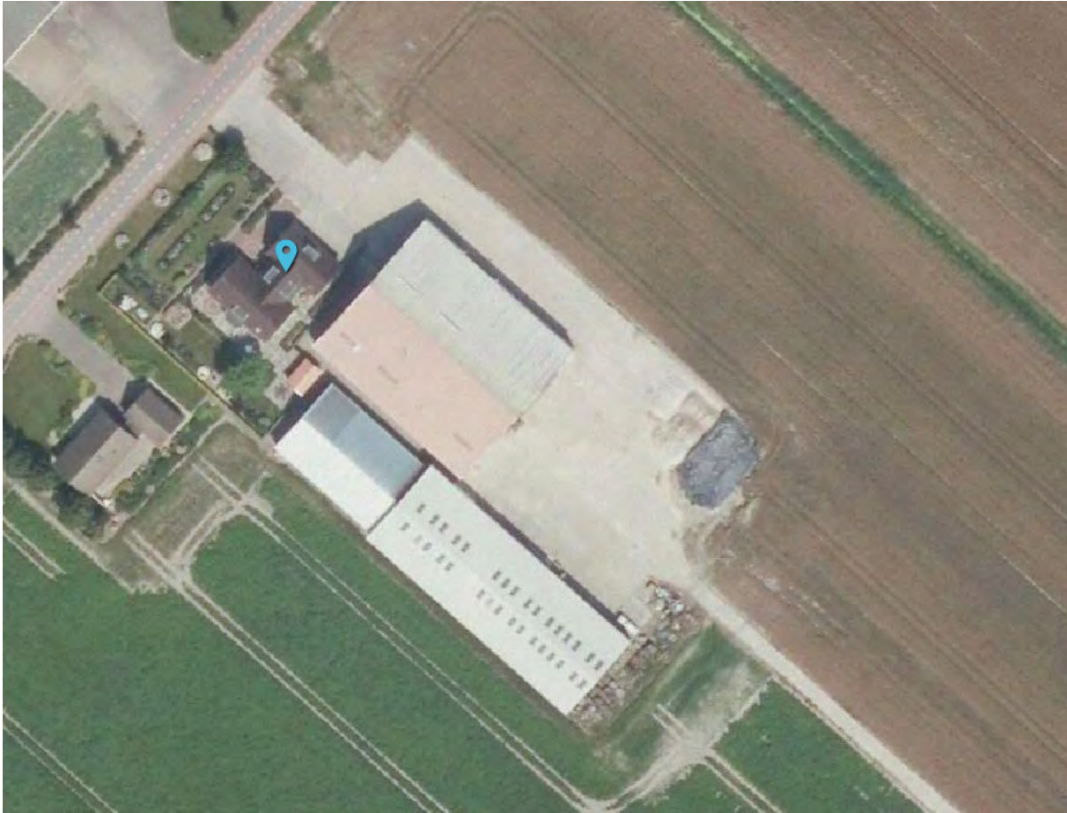
Luchtfoto huidige situatie ter plaatse. Bron: www.ruimtelijkeplannen.nl .
