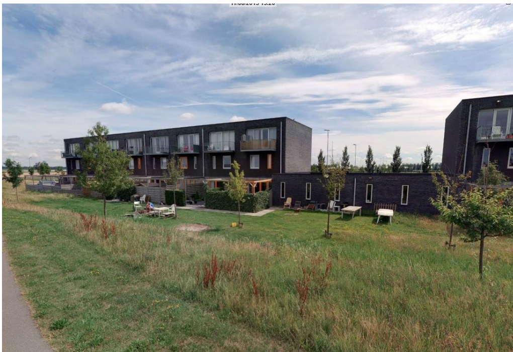
elders in Noordpark gerealiseerd project beneden-bovenwoningen, mét koppeling door bergingen
