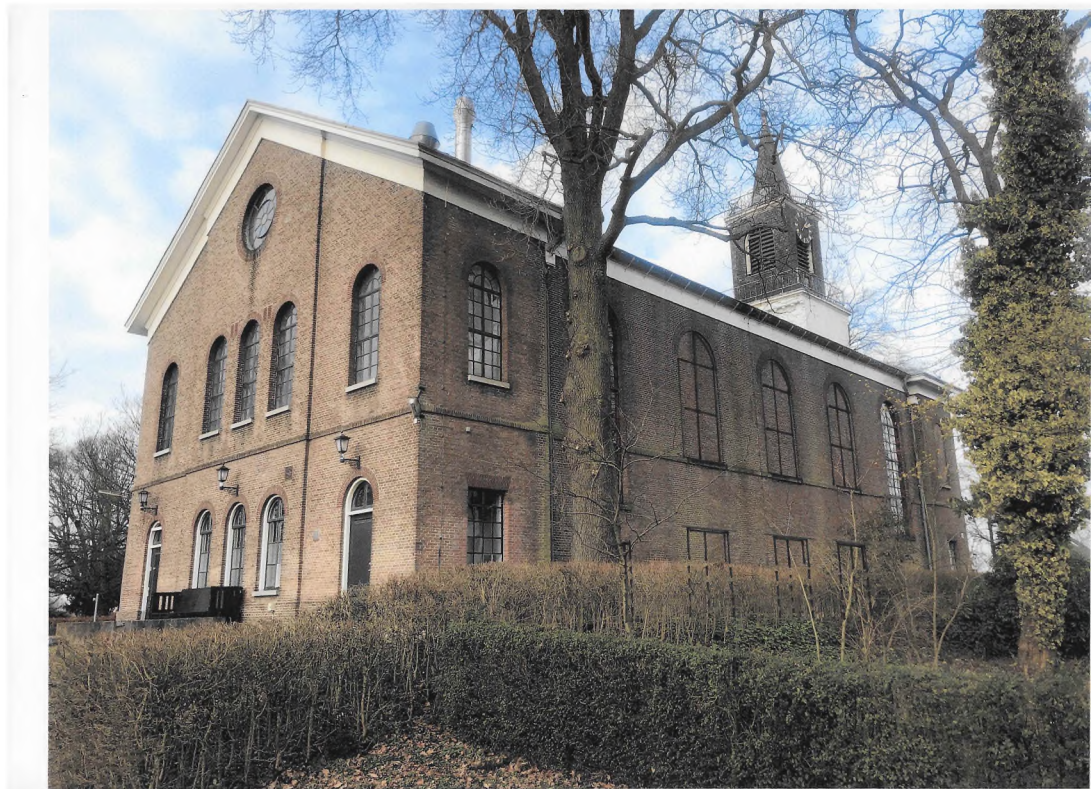
noord-oostgevel blindnissen weer kerkraden, tpv souterrain ook gevelopeningen
