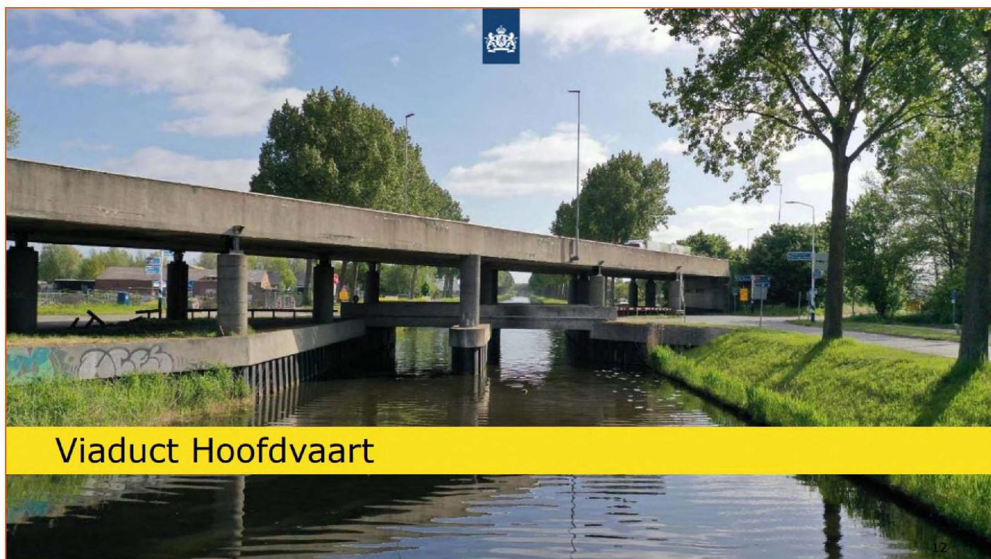
Figuur 1-2 Huidige situatie viaduct Hoofdvaart
