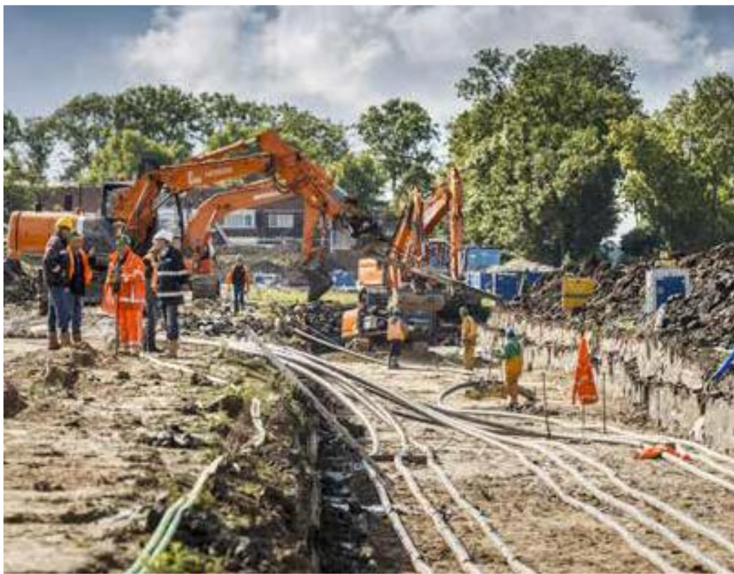
Afbeelding: open ontgraving waarbij de kabels naast elkaar liggen
