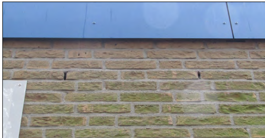
Figuur: het schoolgebouw heeft een aantal spouwmuuren met open stootvoegen welke geschikt zijn voor vleermuizen. Vleermuizen kunnen een verblijfplaatsen hebben in de spouwmuur.
