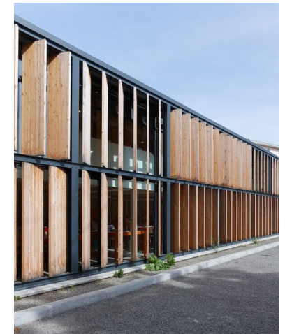
Dynamische gevels door gebruik van lamellen
