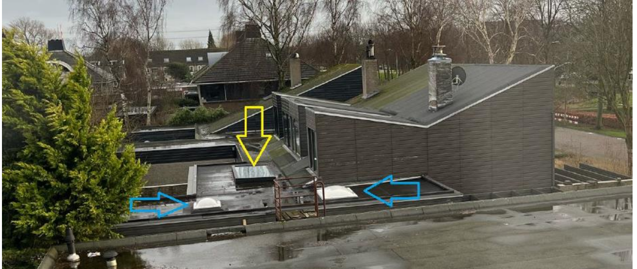
Foto dakramen Vijfhuizenweg 921 vanaf dak/projectlocatie
