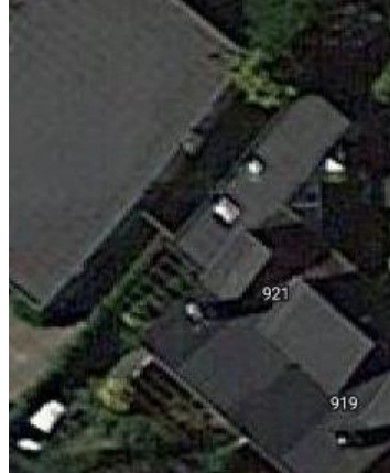
luchtfoto dak bijgebouw
