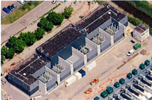
Situatie transformatorgebouw (voorjaar 2022)
