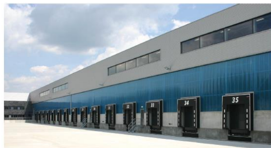
De bebouwing binnen SLP bestaat uit grote bedrijfshallen met relatief kleine kantoorvolumes.
