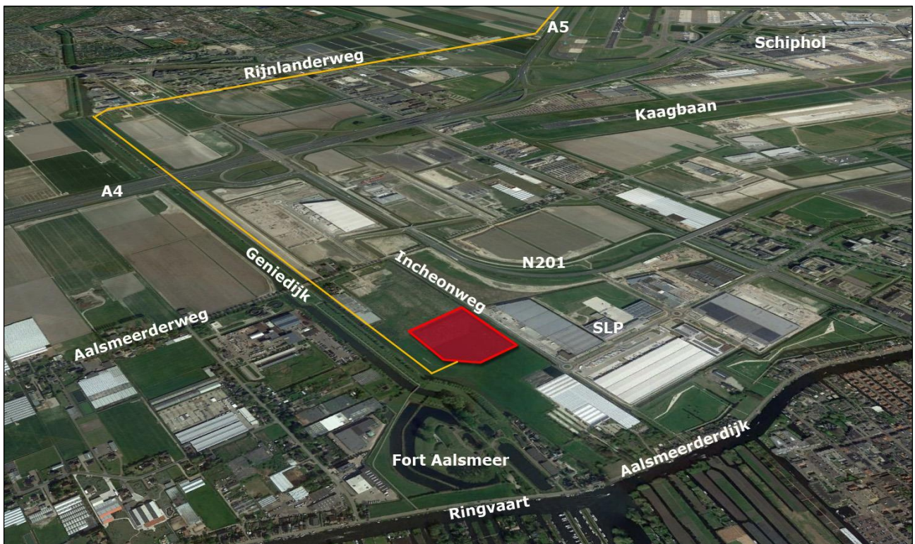
Figuur 2.2: Ligging plangebied op een luchtfoto (vogelvlucht) in relatie tot het zuidelijke deel van het plangebied, in de omgeving van het nieuwe transformatorstation aan de Incheonweg
