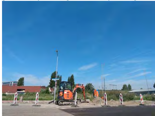
Afbeelding 8. Zuidelijk deel tracé, kruising Hoeklanderweg en Rijnlanderwef. Wegwerkzaamheden gaande aan Rijnlanderweg. Foto in westelijke richting.
