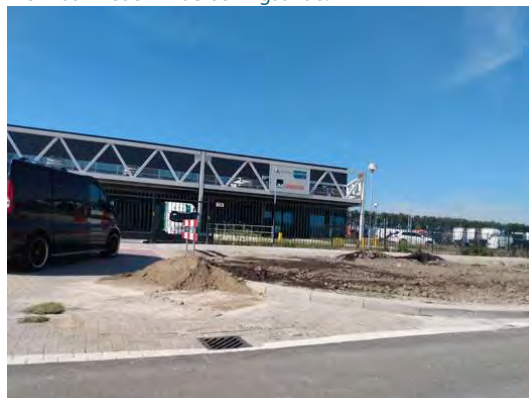
Afbeelding 6. Zuidoostelijk deel tracé, bij rotonde Changiweg; industrieterrein. Verschillende werkzaamheden in de berm gaande.
