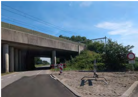
Afbeelding 9. Zuidelijk deel tracé, bij kruising Rijnlanderweg en Tufsteen. Werkzaamheden in de berm.
