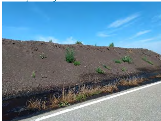
Afbeelding 12. Middendeel tracé, aan Vijfhuizenweg (parallel aan A5). Zwart olieachtig materiaal in berm. Foto in westelijke richting.
