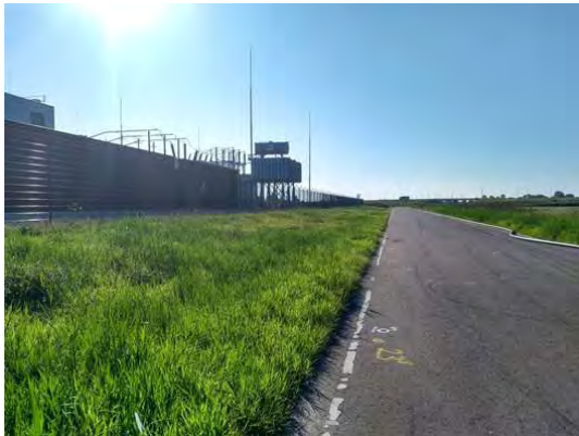
Afbeelding 19. Deelgebied 3, station Vijfhuizen (foto in zuidoostelijke richting).
