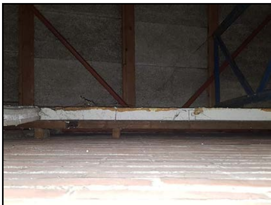
Afbeelding 4: Ruimtes onder isolatiepanelen
