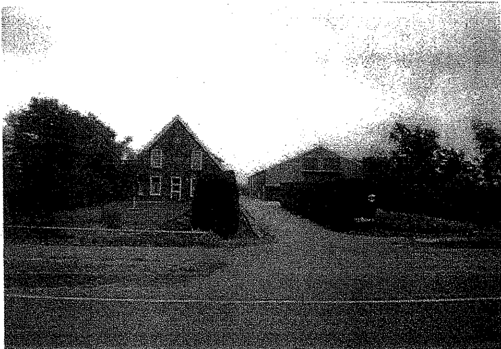
Gezicht vanuit noordwestzijde (Hoofdweg)
