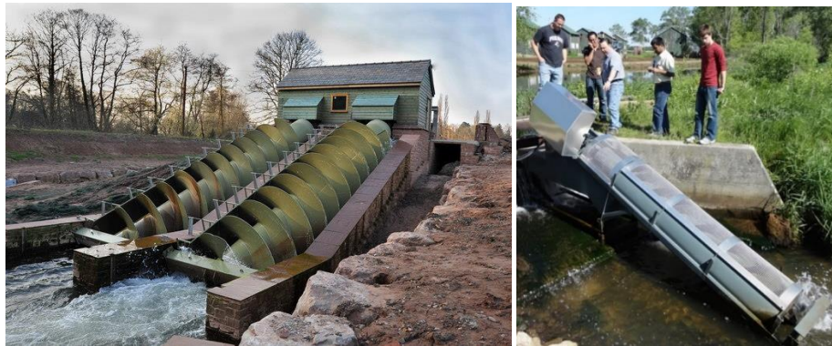
Figuur 7.3: Voorbeeld vijzelturbine (hoog waterpeil verschil)
