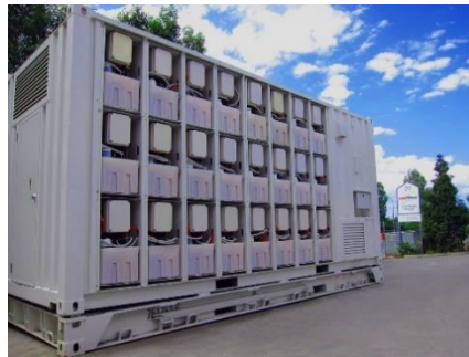
Voorbeeld 'flow' chemische batterij
