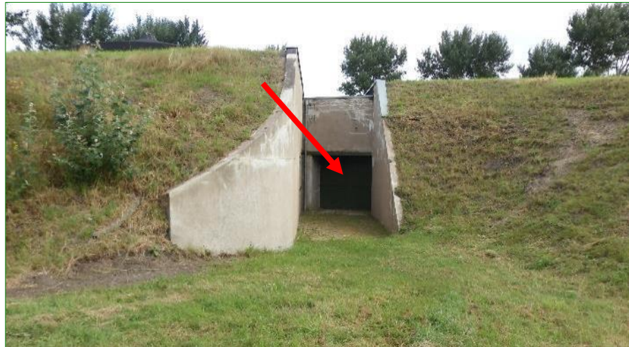
Één van de toegangen aan de westzijde van het fort met kieren langs de deuren. Achter deze deuren zijn potentieel geschikte achterliggende ruimtes voor (overwinterende) vleermuizen.
