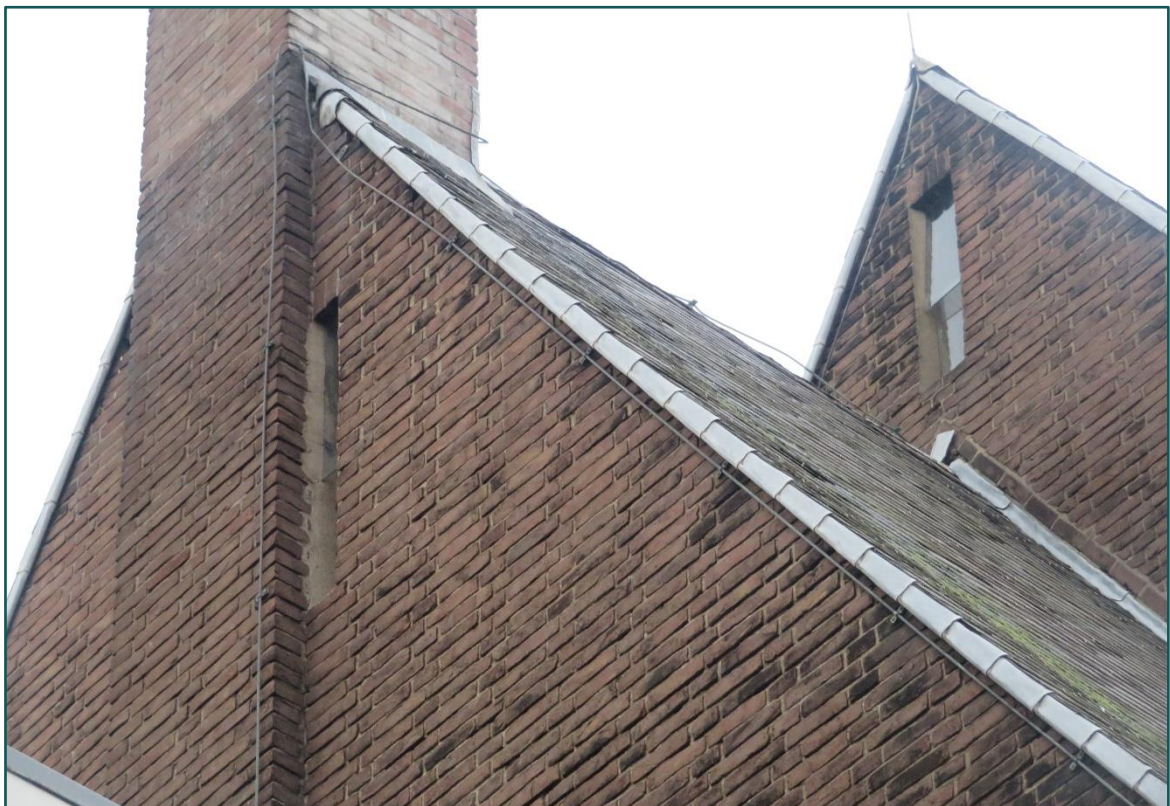
Figuur 4 De kantpannen sluiten alle strak aan.
