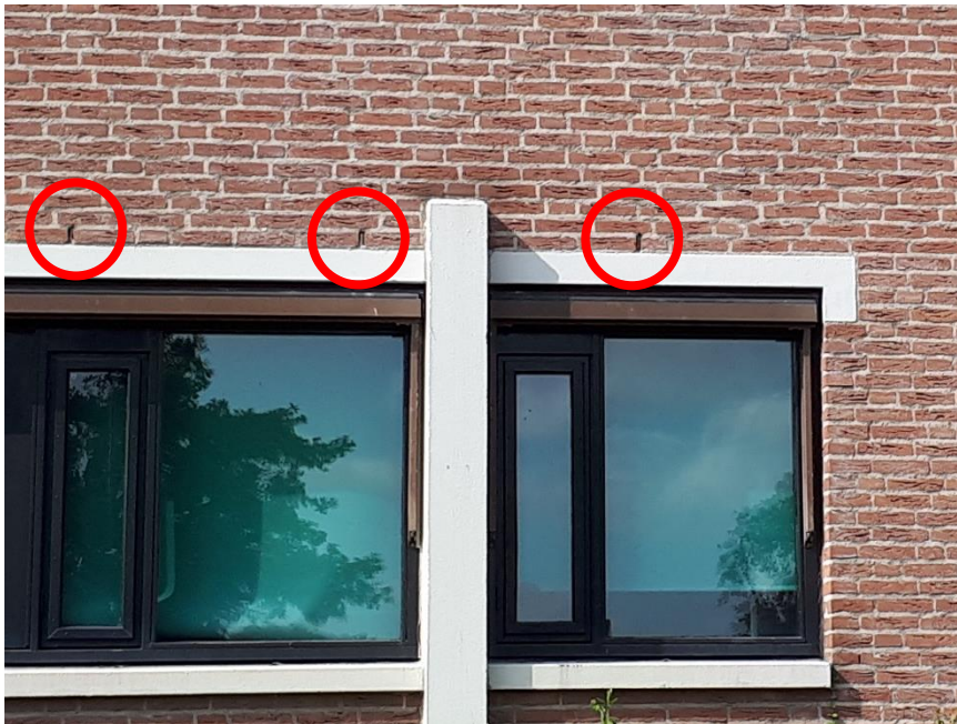
Figuur 3.1. Alle toegangen tot de spouw waren ter grote van kleine stootvoegen zoals hier aangegeven.
