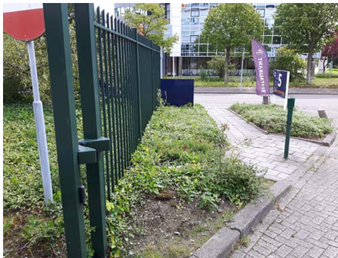
Foto 53: Asbest op maaiveld groenstrook Planetenweg 5
