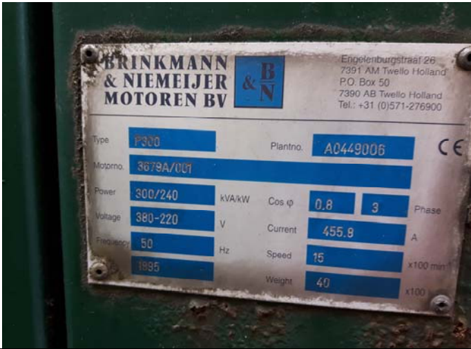
Foto 33: Noodstroomaggregaat informatieplaatje
