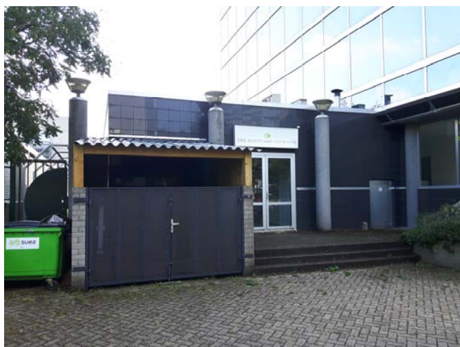
Foto 17: Container voor restafval en opslagblok overig materiaal
