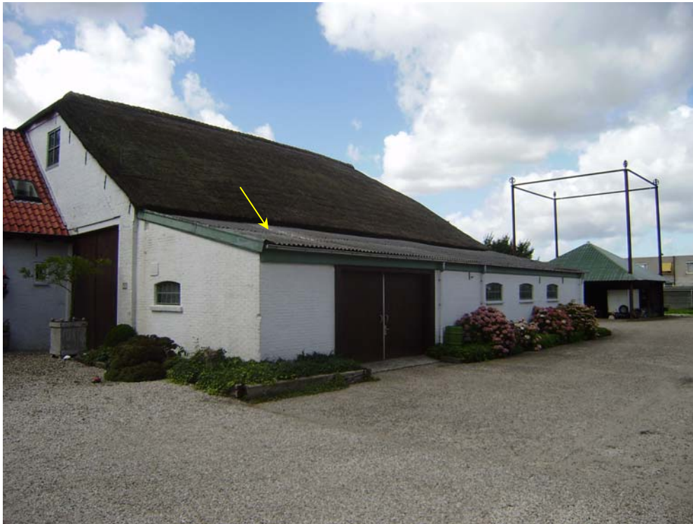
Foto 1: Gezicht op de asbesthoudende golfplaten op een deel van het dak.
