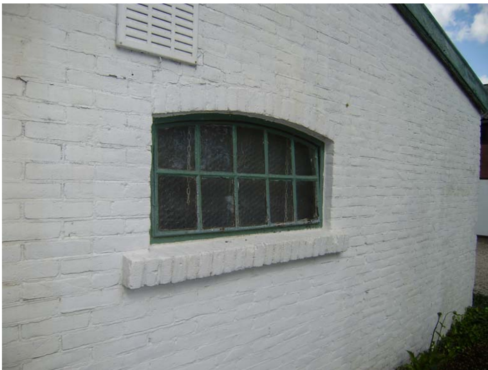
Foto 2: Gezicht op de niet asbesthoudende stopverf in één van de ramen.
