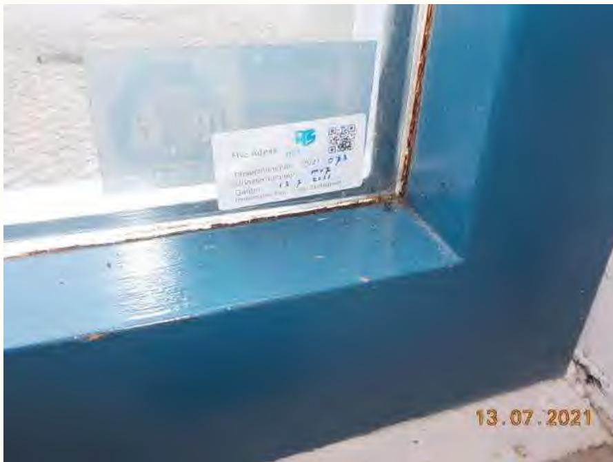
Foto 13: Bron B04, asbestvrije beglazingskit
