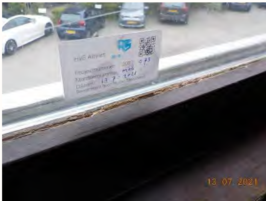
Foto 11: Bron B04, asbestvrije beglazingskit
