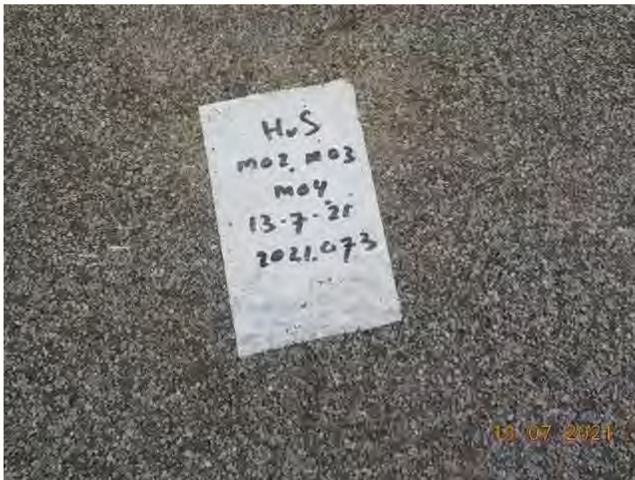
Foto 9: Bron B03, asbestvrije dakbitumen, 3 lagen
