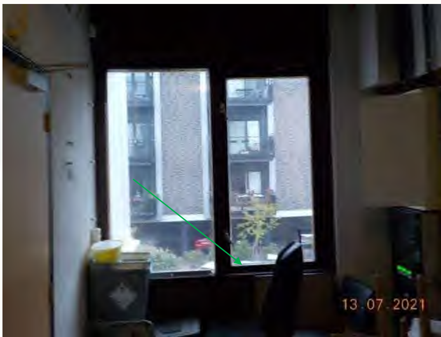
Foto 10: Bron B04, asbestvrije beglazingskit
