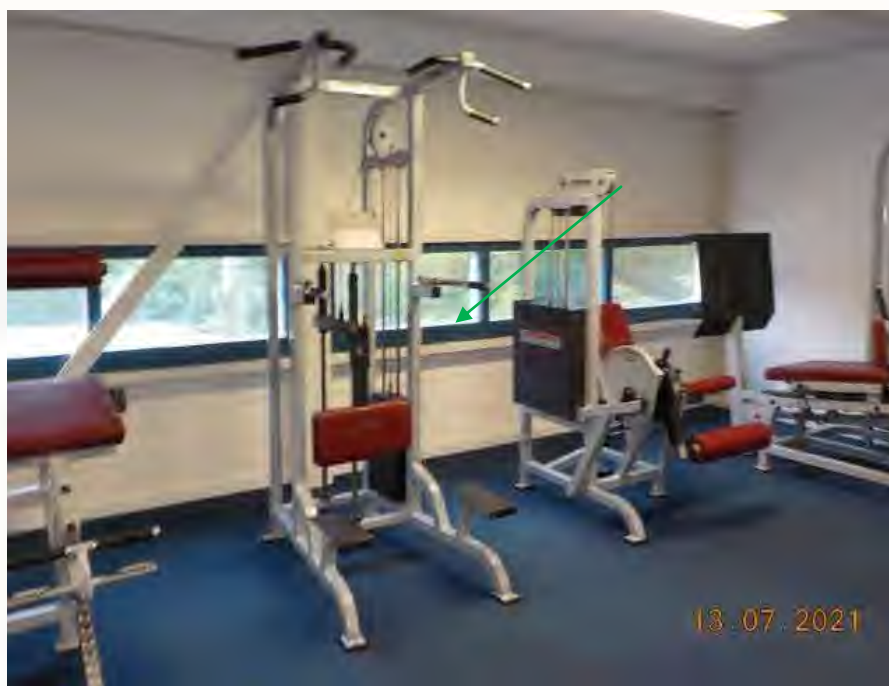
Foto 12: Bron B04, asbestvrije beglazingskit
