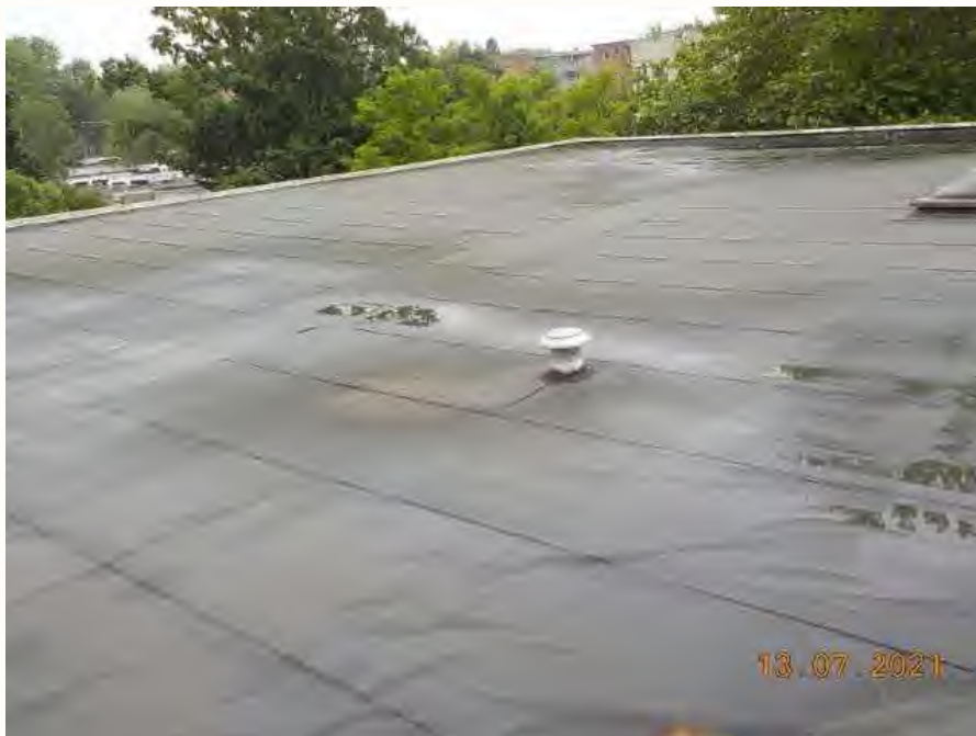
Foto 7: Bron B03, asbestvrije dakbitumen, 3 lagen
