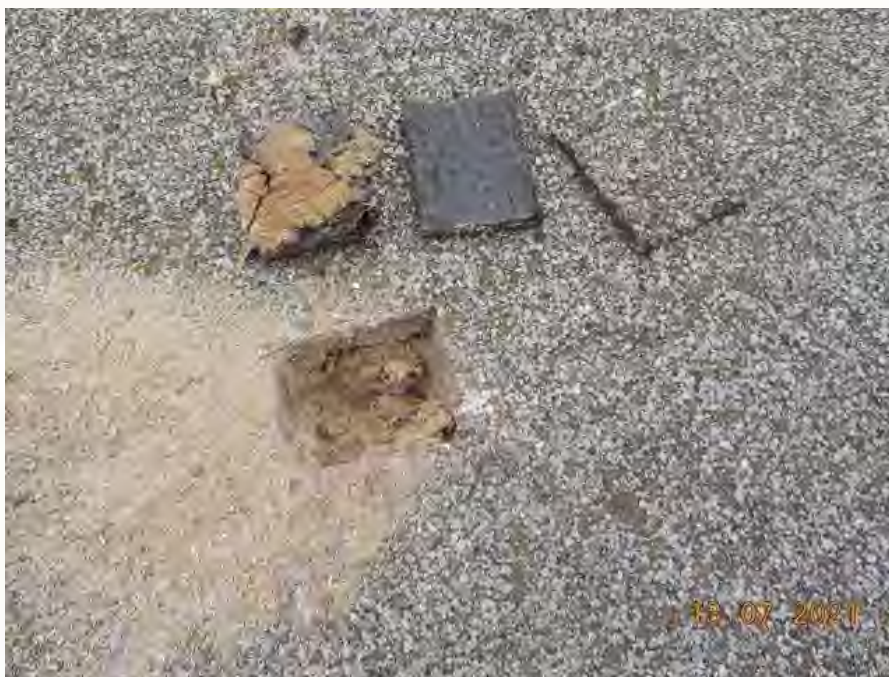
Foto 8: Bron B03, 3 lagen asbestvrije dakbitumen
