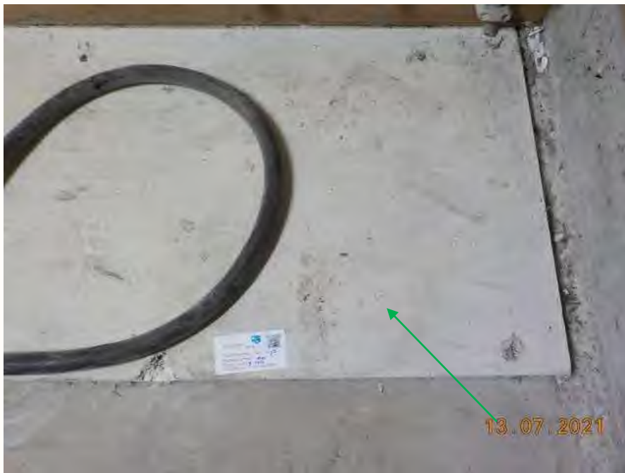
Foto 3: Bron B02, Asbestvrije beplating, cv ruimte
