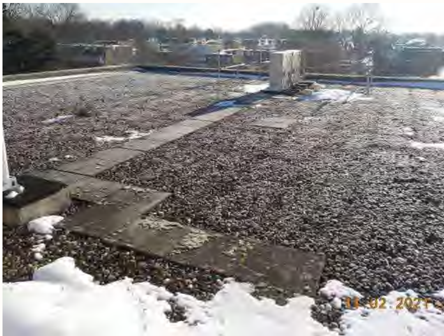
Foto 13: Bron B06, asbestvrije dakbitumen
