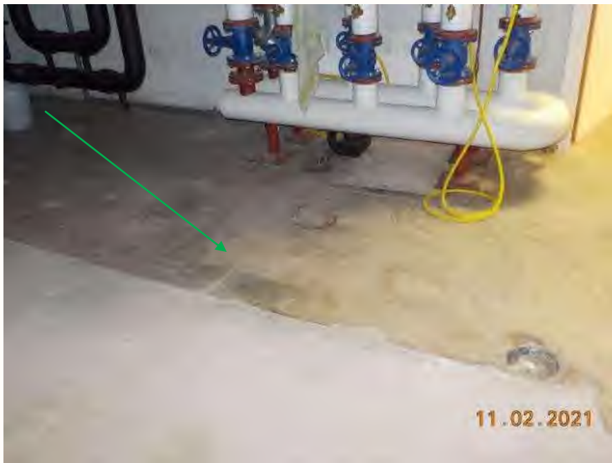
Foto 9: Bron B04, asbestvrije vloerafwerking, dakopbouw
