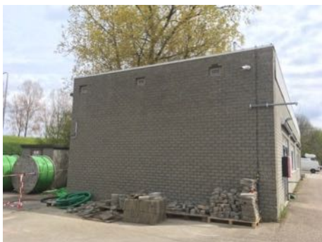
Figuur 8. Noordkant plangebied met gebouw nr. 5.
