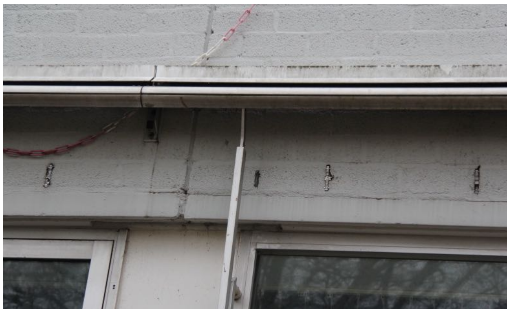
Figuur 13. Detail van de gevel van het complex aan de Hoofdweg met afgesloten open stootvoegen (midden) en afgekitte dilatatievoeg.
