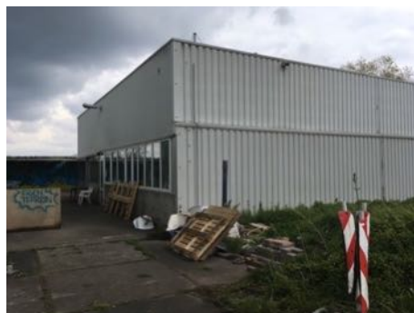
Figuur 9. Noordwesthoek plangebied met links gebouw nr. 6.
