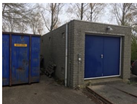
Figuur 7. Noordkant plangebied met gebouw nr. 4.
