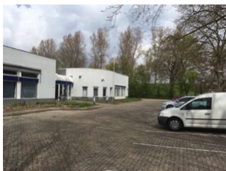
Figuur 6. Oostzijde van gebouw nr. 3 aan de Hoofdweg 581-583.
