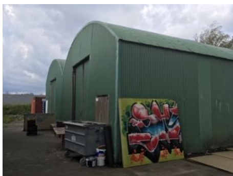
Figuur 11. Gebouw nr. 7.
