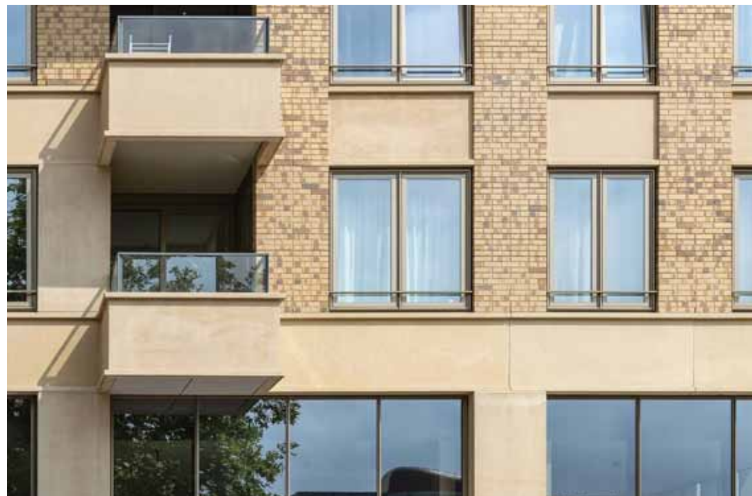
zandkleurige betonbanden en balkons in combinatie met geel metselwerk
