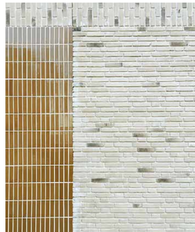
verbijzonderingen in het metselwerk door toepassing van geglaazuurde bakstenen
