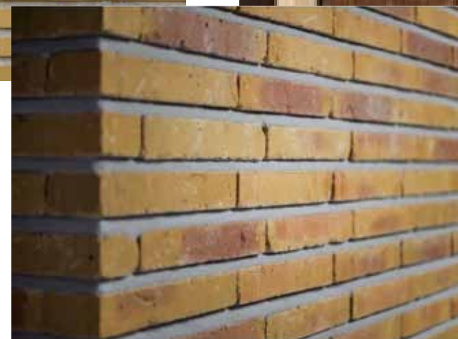
stootvoegloos metselwerk met schaduwvoeg
