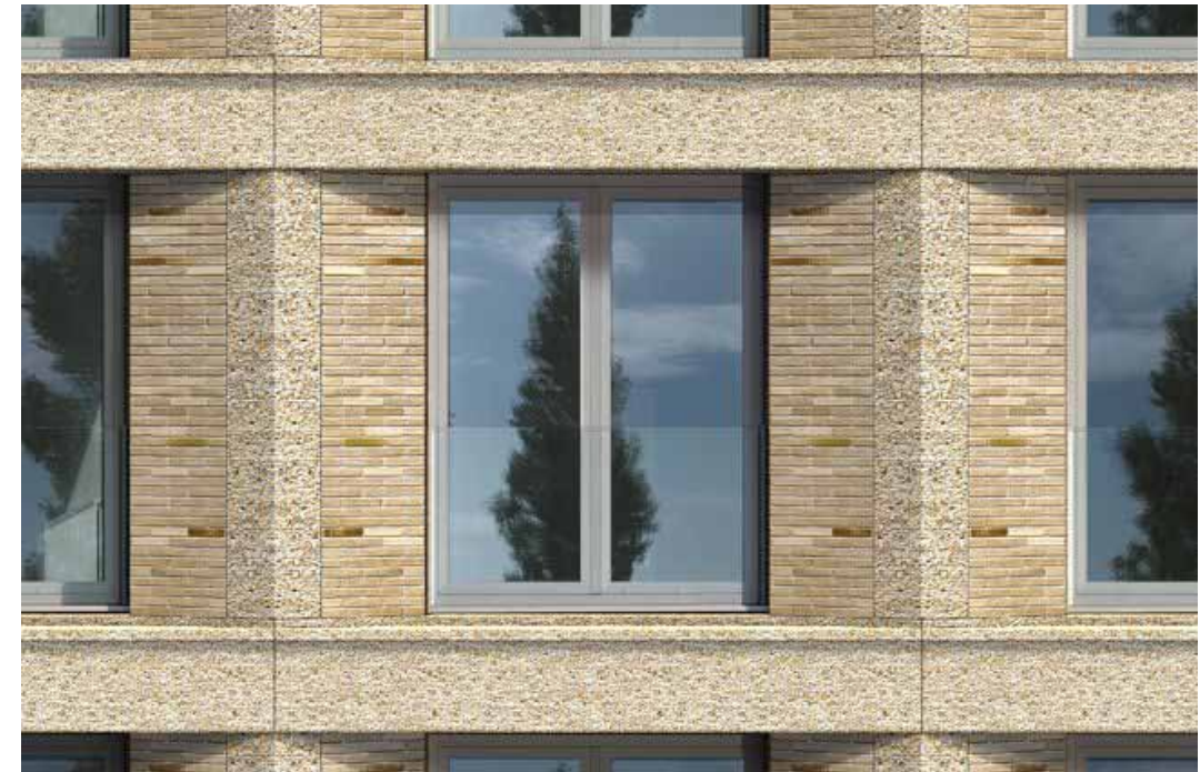
metselwerk in ton-sur-ton combinatie met uitgewassen beton detaillering
