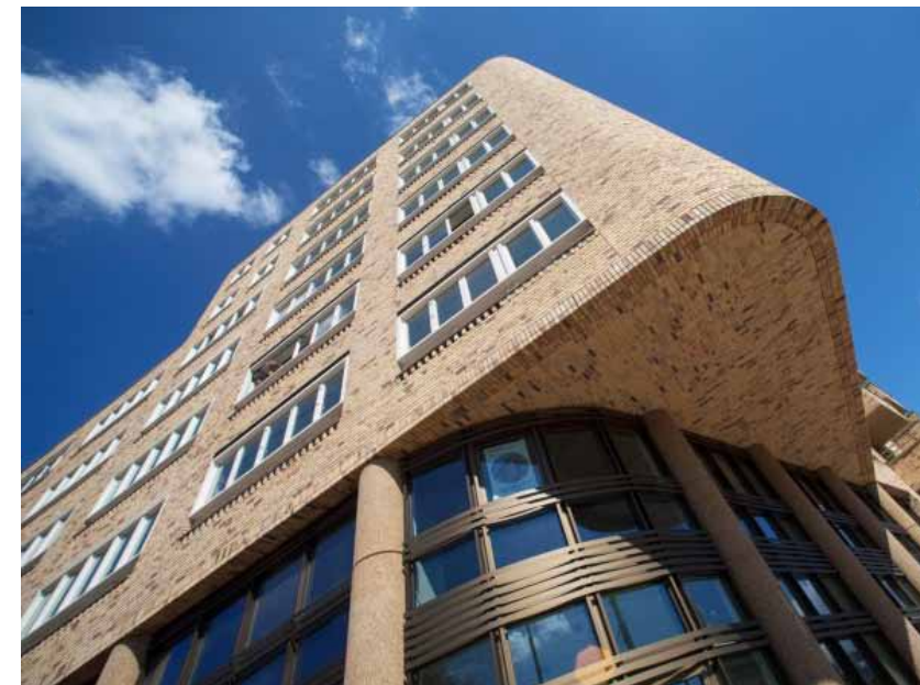
metselwerk in ton-sur-ton combinatie met uitgewassen beton detaillering
