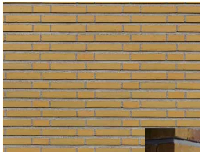
noors kettingverband met schaduwvoeg
