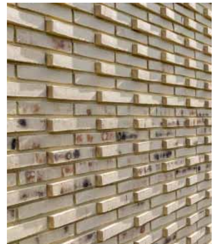
strekken zijn schuin uit het vlak vermetseld, om en om per laag
