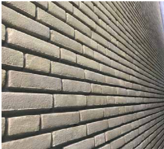
een diepliggende schaduwvoeg (in lichte kleur) is wel toegestaan
