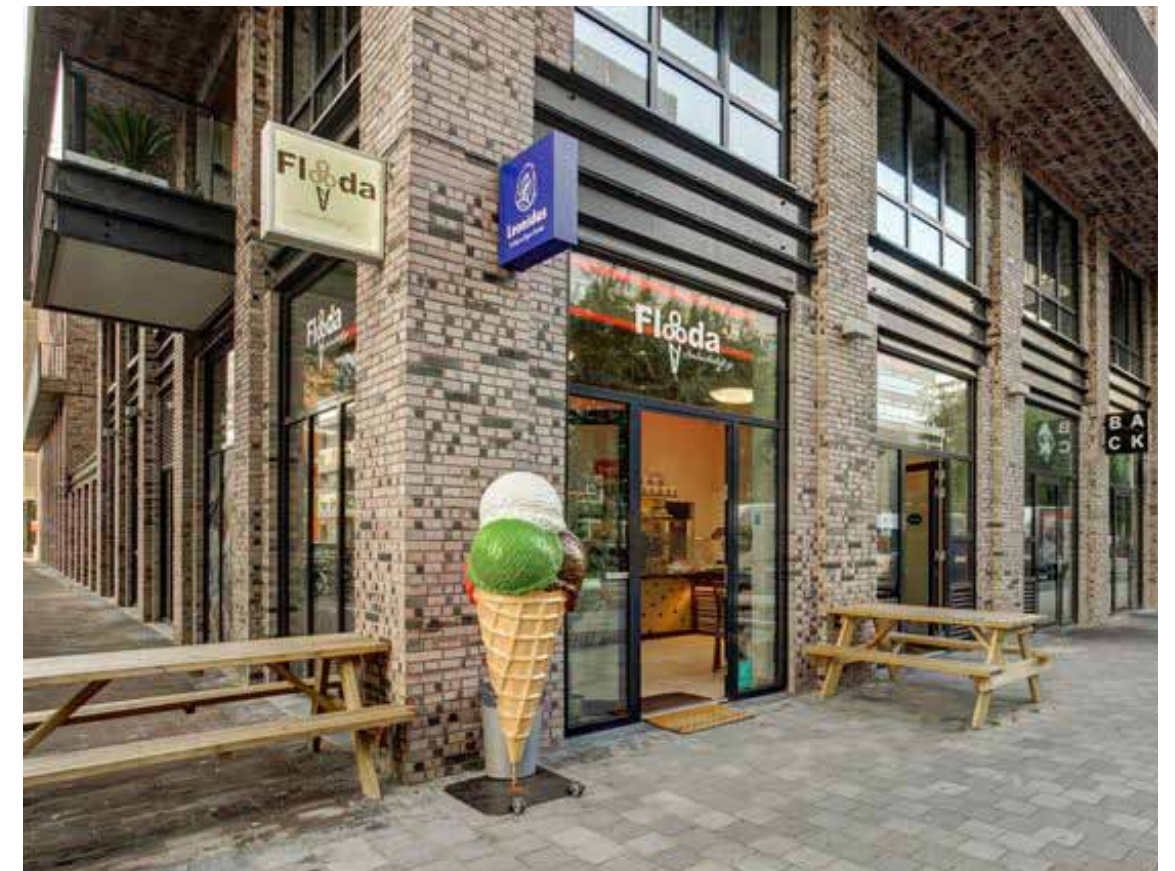
grote openingen in de plint, onderdeel van gevelarchitectuur
