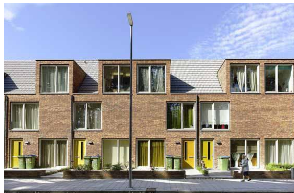
gemetselde dakkapellen en een schuine kap geven mooie afwisseling
