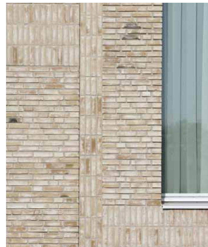
subtiel wisselingen in diepte en staand en liggend metselwerk
