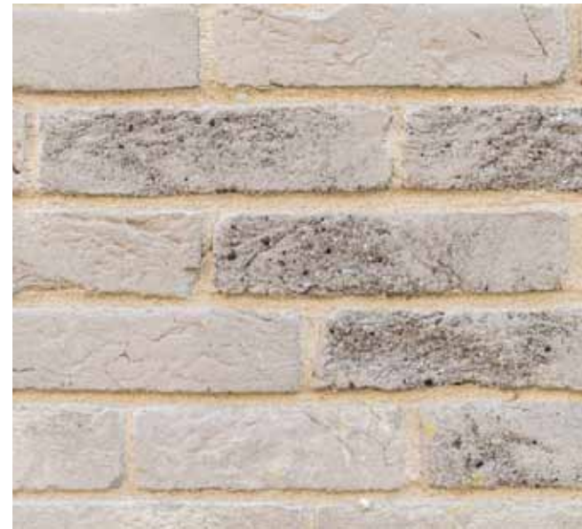
ton-sur-ton kleuren van voegwerk en baksteen
