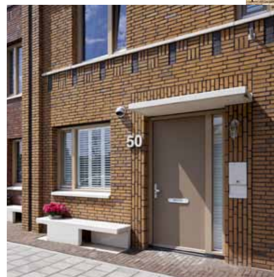
Luifel en een bankje in beton
