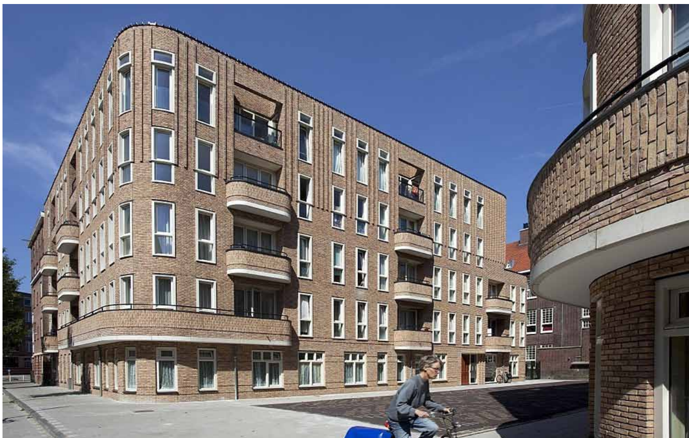
rijke detaillering van de gevels, door de ronde hoek loopt de architectuur door de hoek om
