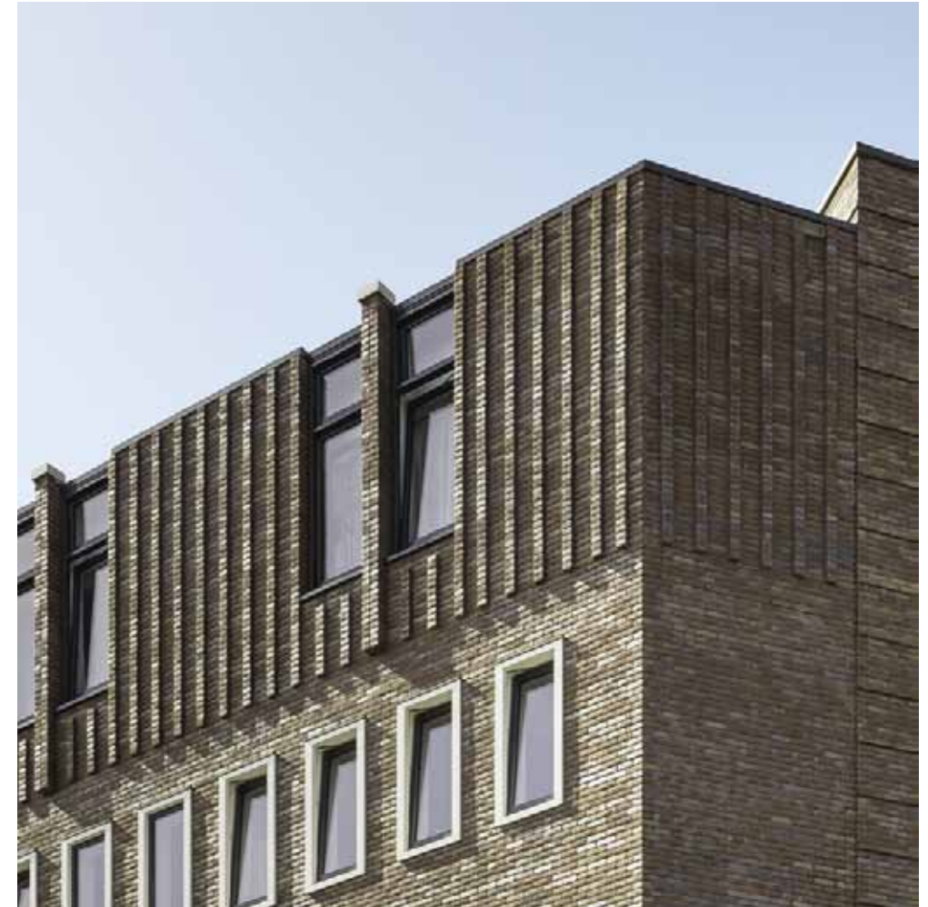
middels fraaie detaillering een verbijzonderde bovenste laag
