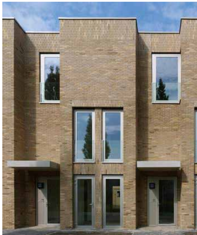
wisselingen in diepte van de volumes zijn ook zichtbaar in de dakrand
