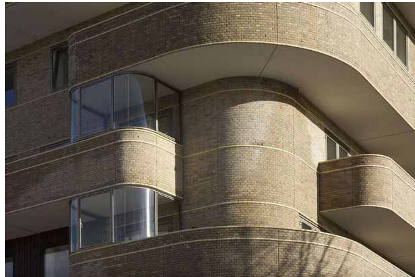
subtiele lijnen van geglazuurde stenen benadrukken de vloeiende vormgeving
