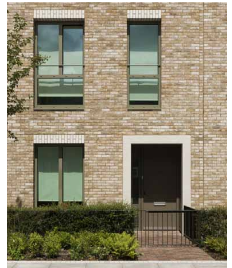
bijzondere betonomlijsting entree, werkt samen met witte rollaag boven kozijnen
