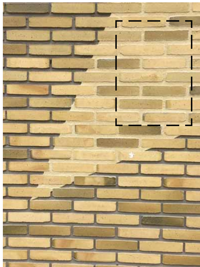
de invloed van voegkleur op het metselwerk is groot een lichte kleur zorgt voor vlakwerking in het metselwerk
