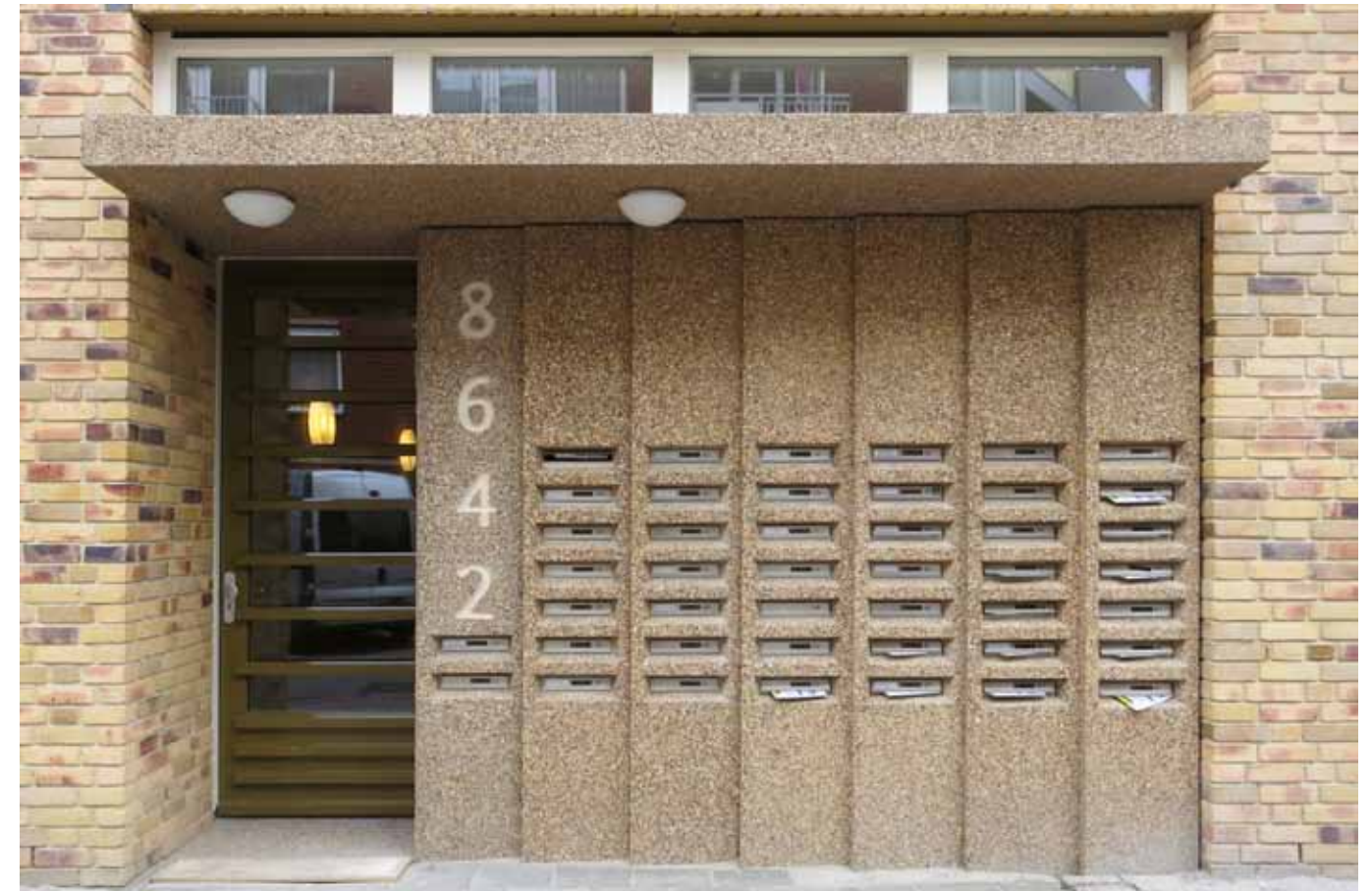
fraaie details met luifel, brievenbussen en huisnummer in uitgewassen grindbeton
